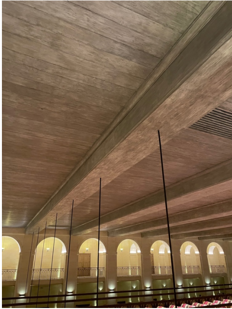
Figure 28 – le plancher poutre
